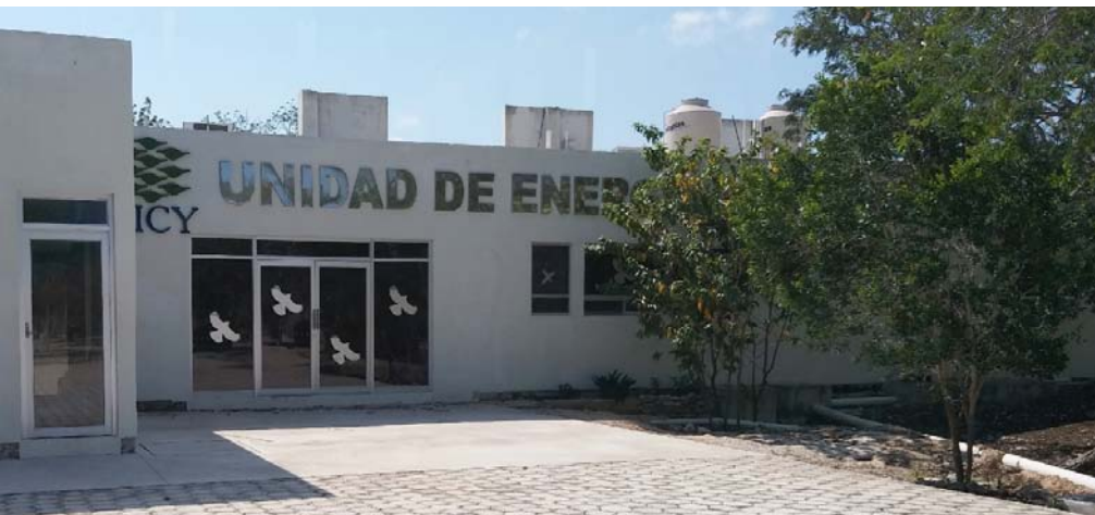
FIGURA 1. Entrada al edificio principal del edificio de la Unidad de Energía Renovable del Centro de Investigación Científica de Yucatán.
