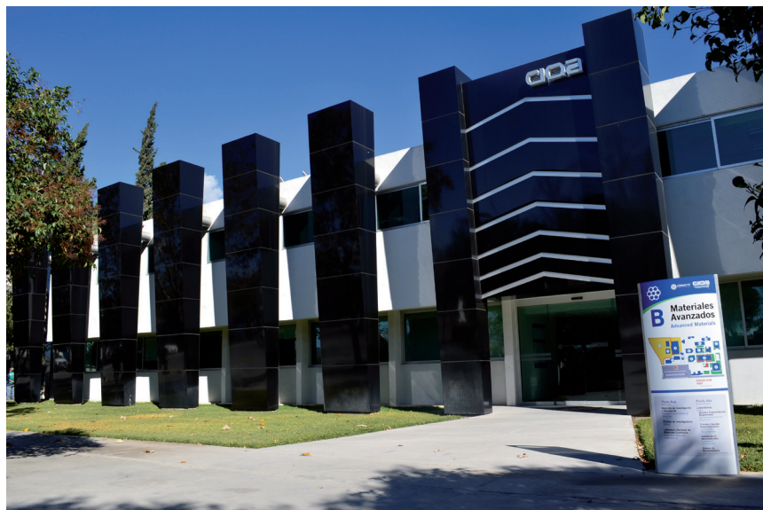
IMAGEN 2. Edificio del Departamento de Materiales Avanzados.
