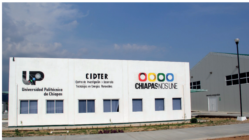
FIGURA 2. Edificio Administrativo del Centro de Investigación y Desarrollo Tecnológico en Energías Renovables.
