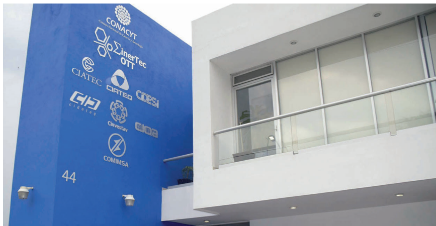
FIGURA 3. Así luce el muro principal de la Unidad Corregidora donde se alberga el Organismo de Transferencia de Tecnología–SinerTec OTT. Recientemente inaugurada el 10 de junio de 2016.
