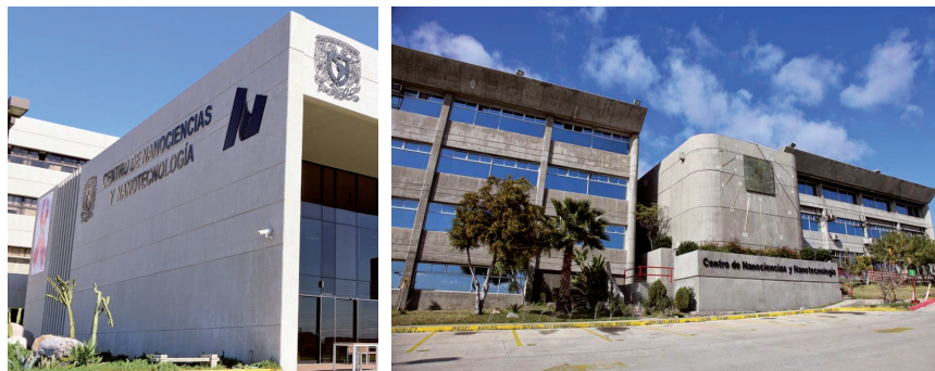
FIGURA 1. Vista general de los edificios del Centro de Nanociencias y Nanotecnología.
